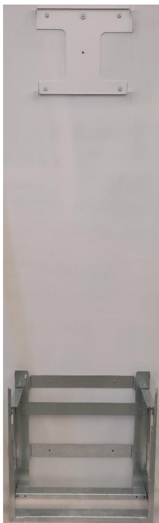
Figura 7 – Staffa inverter e WALL-BOX-Bx BASE fissati a parete
