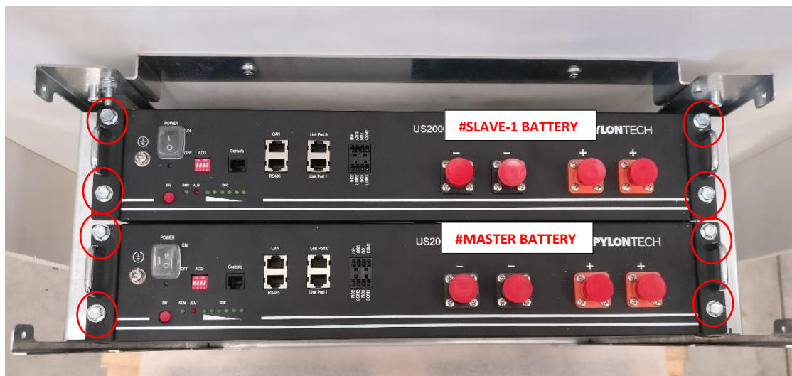
Figura 10 – Fissaggio moduli batteria al box batteria
